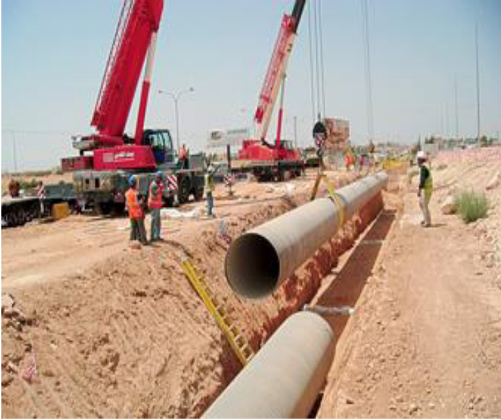
جانب من أعمال تمديد المواسير في مشروع جر مياه الديسي
