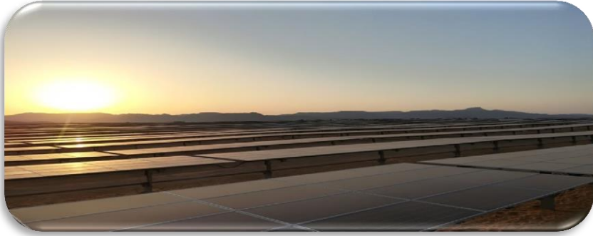
مشروع الطاقة المتجددة لتوليد الكهرباء - الطاقة الشمسية / العقبة
